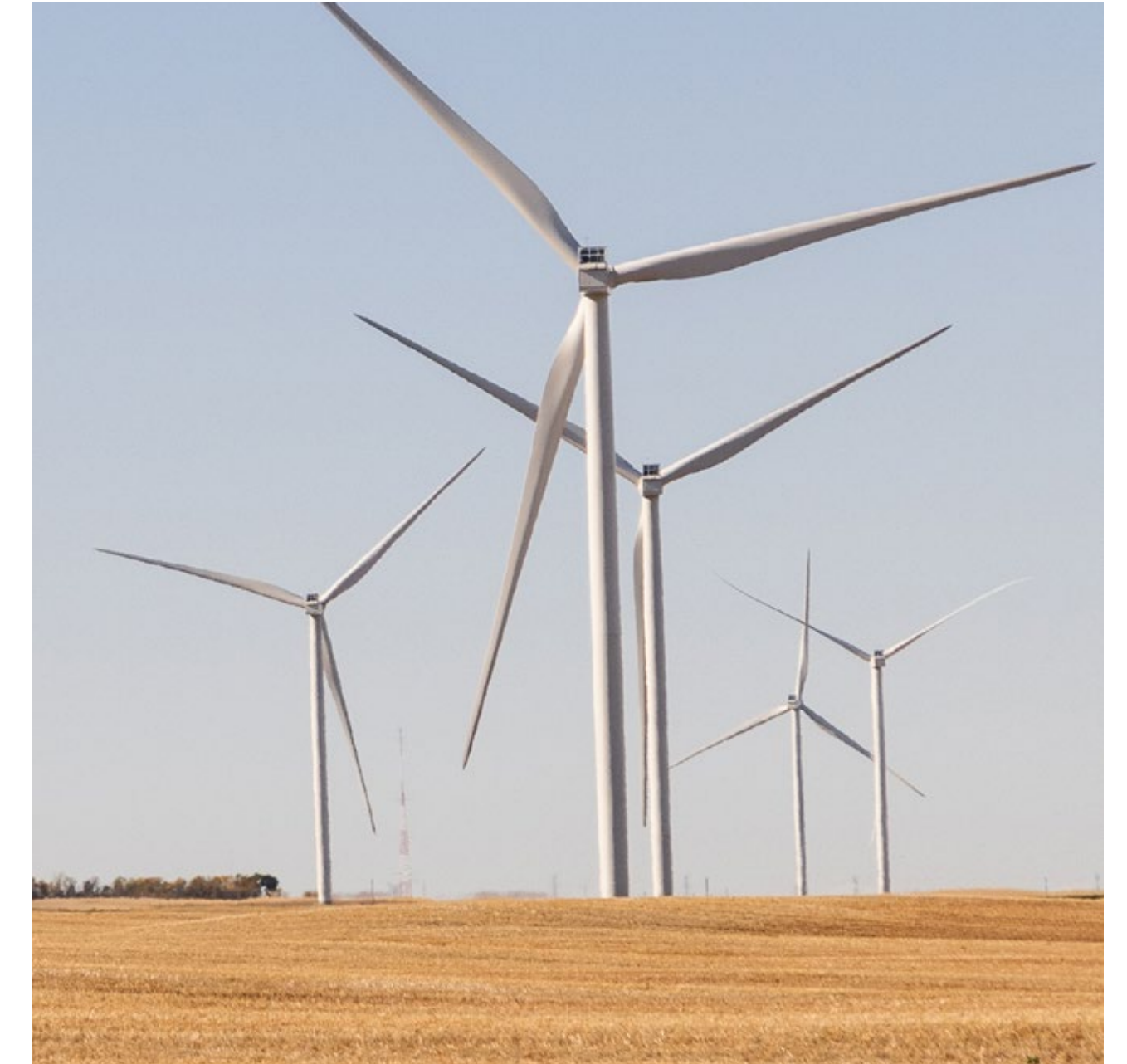
Cypress 1 et 2, projets éoliens Alberta, Canada | EDF Renouvelables
